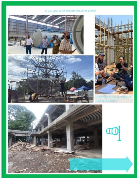
Gambar 3.4 Kegiatan Pembangunan, Pengawasan dan Pengendalian Bangunan Gedung
