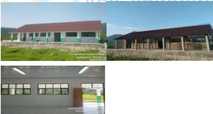
Gambar 5. Pembangunan Unit Sekolah Baru SMP Negeri
